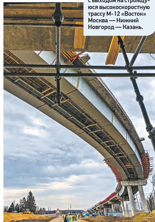
На строящемся участке будет построено четыре эстакады и два тоннеля
