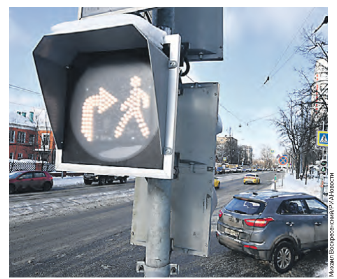
5 февраля. Новый светофор с совмещенной фазой на пересечении Краснобогатырской улицы и Алымова переулка
