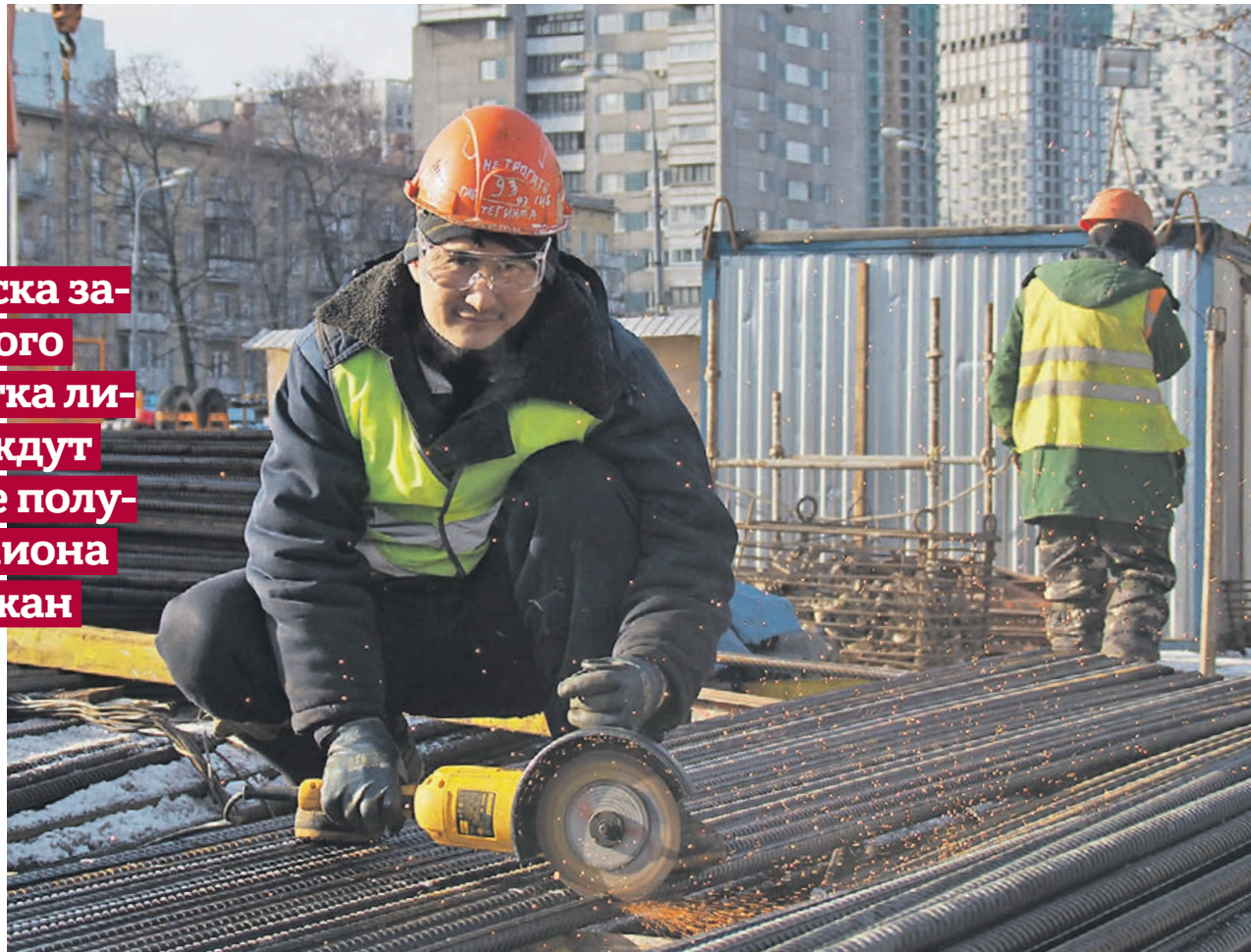
15 февраля 2020 года. Заготовщик арматуры Гиоз Игамверджиев на строительстве БКЛ станции «Улица Народного Ополчения»
