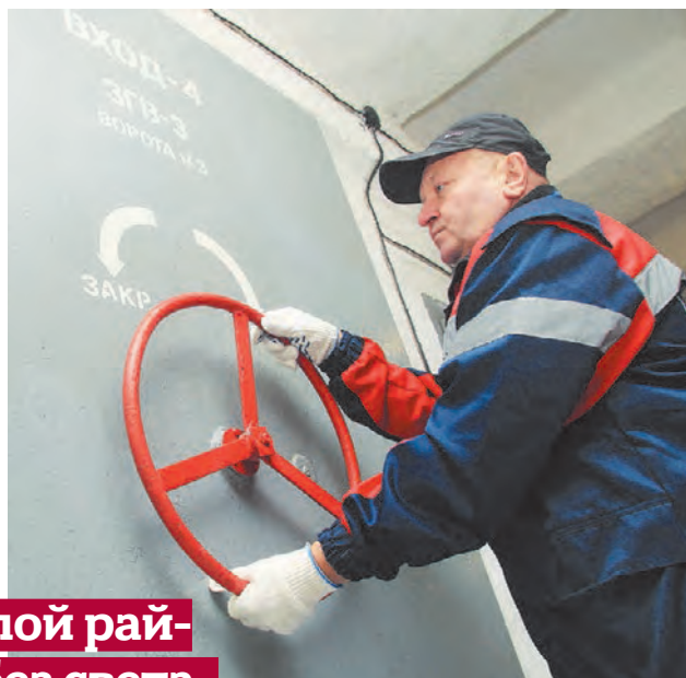
2 октября 2017 года. За состоянием защитного убежища постоянно следят техники и инженеры
