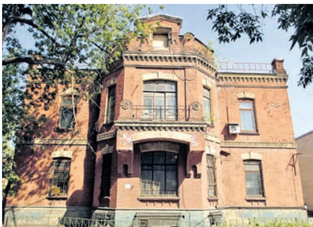
21 июля 2014 года 15:00 Здание старинного военного госпиталя в Лефортове строилось для лечения русских солдат и офицеров, раненных в битвах Первой мировой войны
