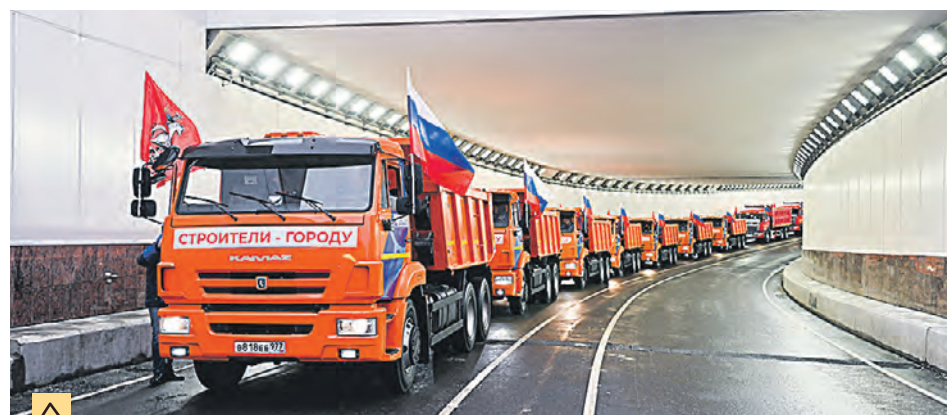
11 декабря. Открыт тоннель под путями МЦД-4, соединивший районы Бутырский и Марьина Роща
