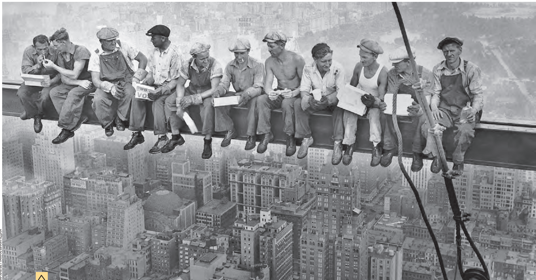
2 октября 1932 года. Постановочное фото, известное как «Обед на вершине небоскреба», сделано как раз на строящейся башне «Эмпайр-стейт-билдинг»
