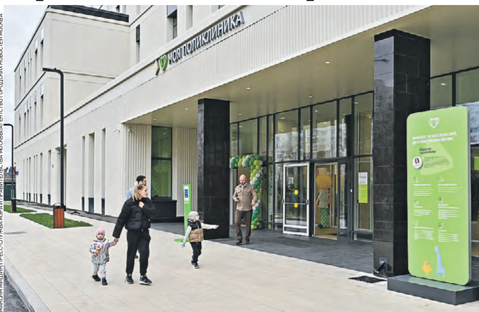
12 апреля. Здание новой детской поликлиники на улице Лебедянская в районе Бирюлево Восточное
