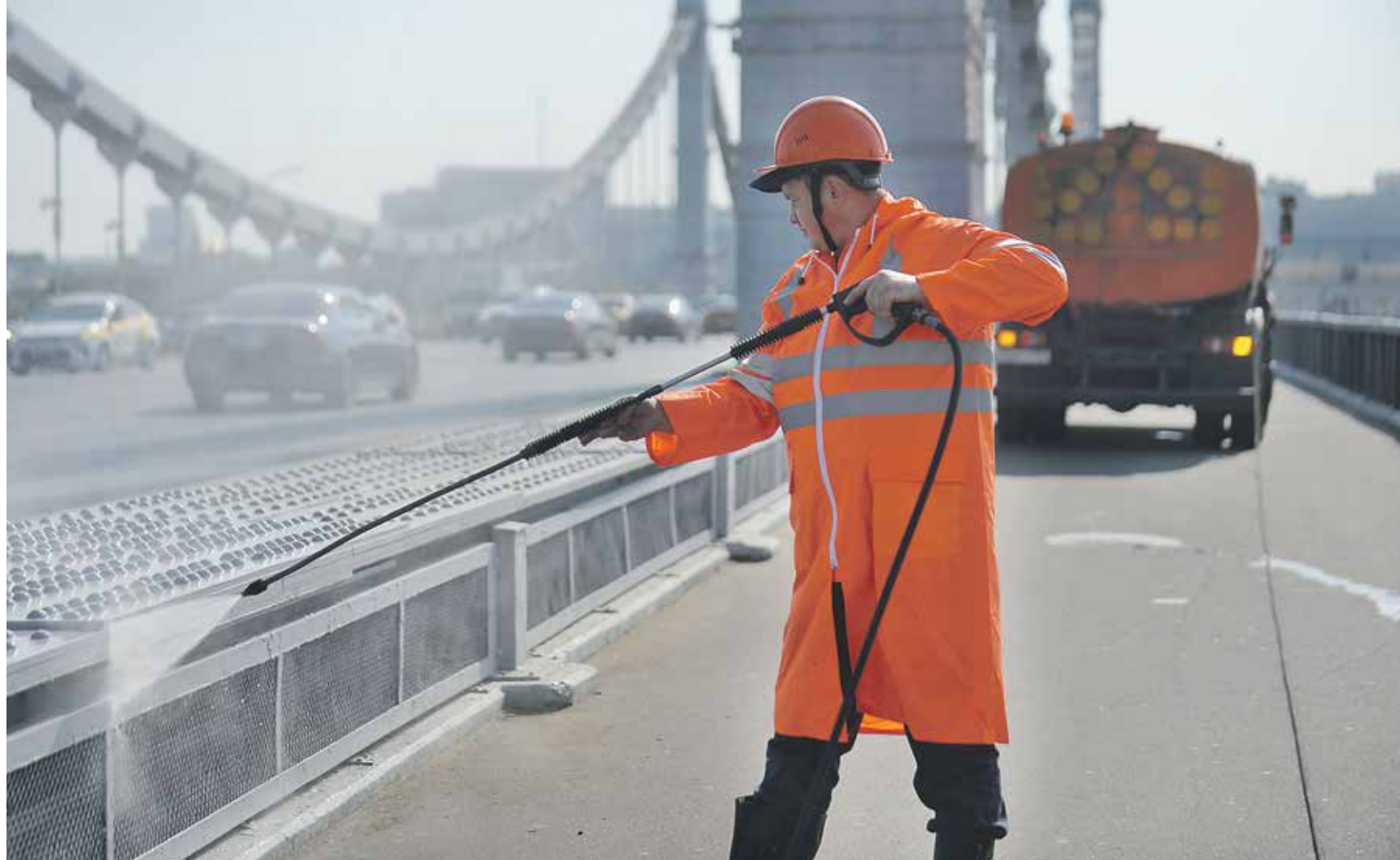
10 октября. Дорожный рабочий ГБУ «Горьмост» Александр Рыннин моет конструкции Крымского моста. Такие работы традиционно проводятся при подготовке города к летнему и зимнему сезонам. Фото: Александр Кочубей
