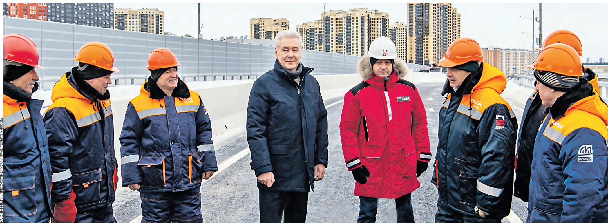
11 января 11:48 Мэр Москвы Сергей Собянин (в центре) вместе с генеральным директором компании «Дороги и мосты» Алексеем Крапивиным (справа от мэра) и строителями открывает движение по третьему участку новой магистрали Солнцево — Бутово — Варшавское шоссе от Боровского до Киевского шоссе
