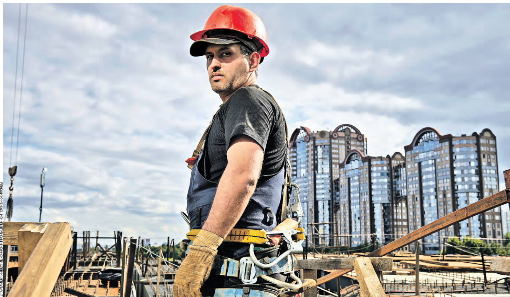
23 сентября 12:47 Строитель Ильгис Абдурасулов участвует в возведении Северного дублера Кутузовского проспекта. Работы идут практически круглосуточно — это нужно, чтобы запустить движение по новой магистрали в следующем году
