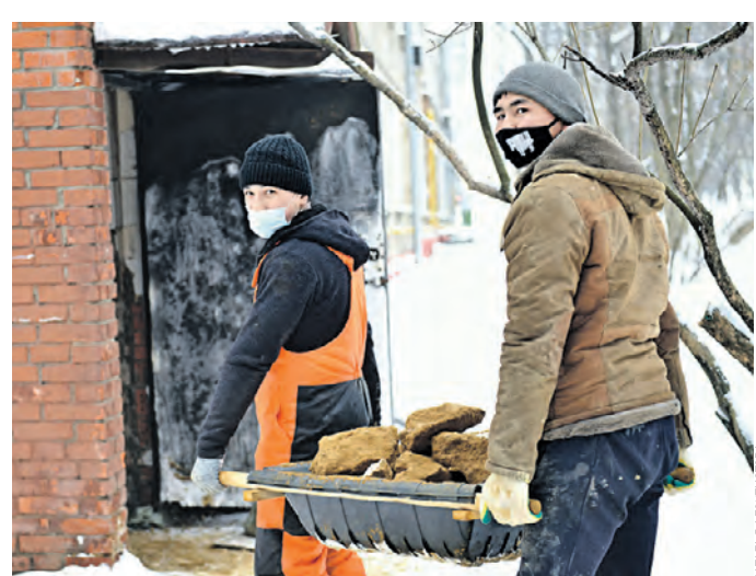
22 января 10:27 Абдурахман Лахманджонов и Мухтар Саиджонов возвращают грунт в отремонтированный подвал
