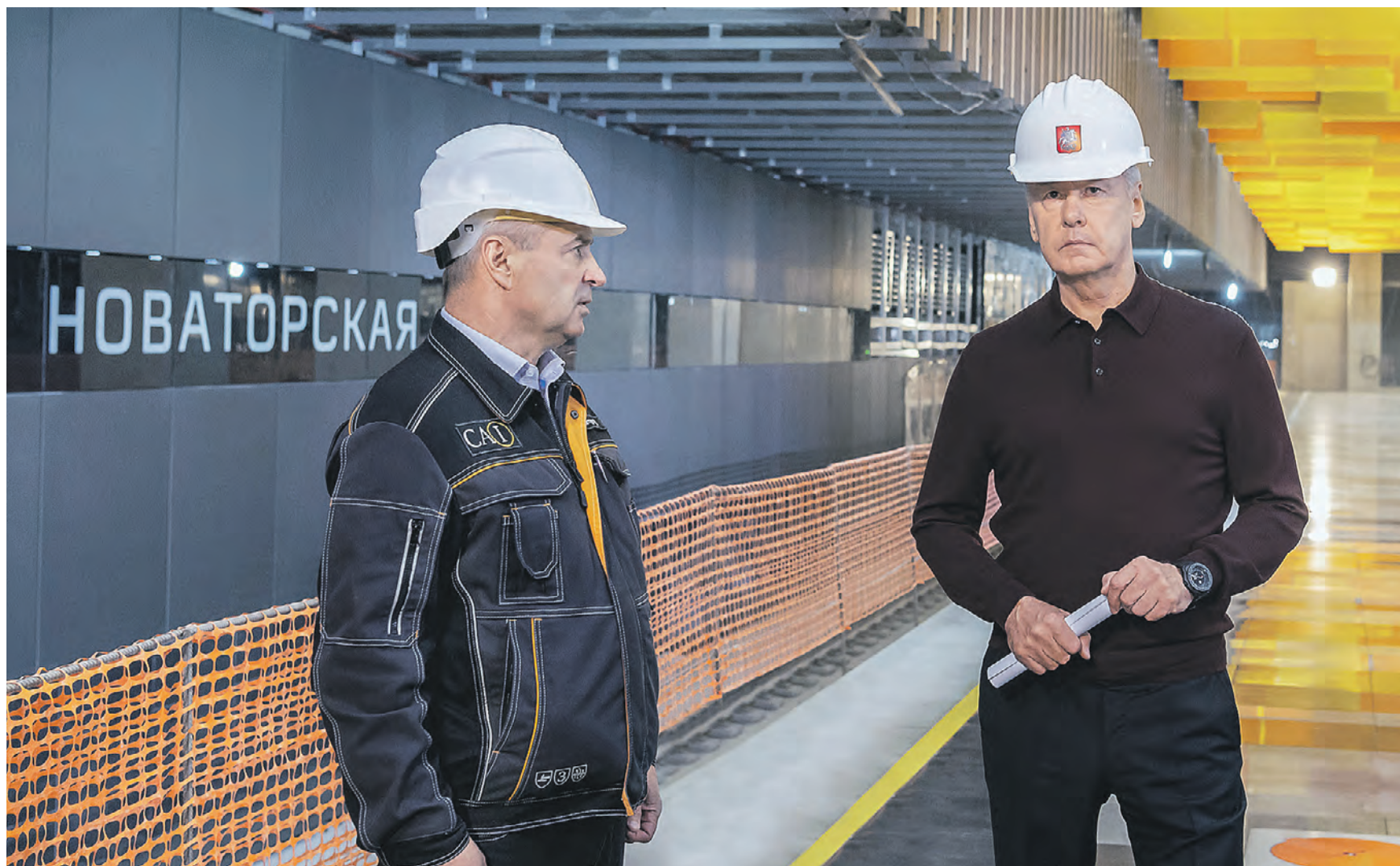
Вчера 15:18 Мэр Москвы Сергей Собянин (справа) и председатель совета директоров компании-подрядчика Владимир Петрук осмотрели ход строительства станции «Новаторская» Большой кольцевой линии метро
