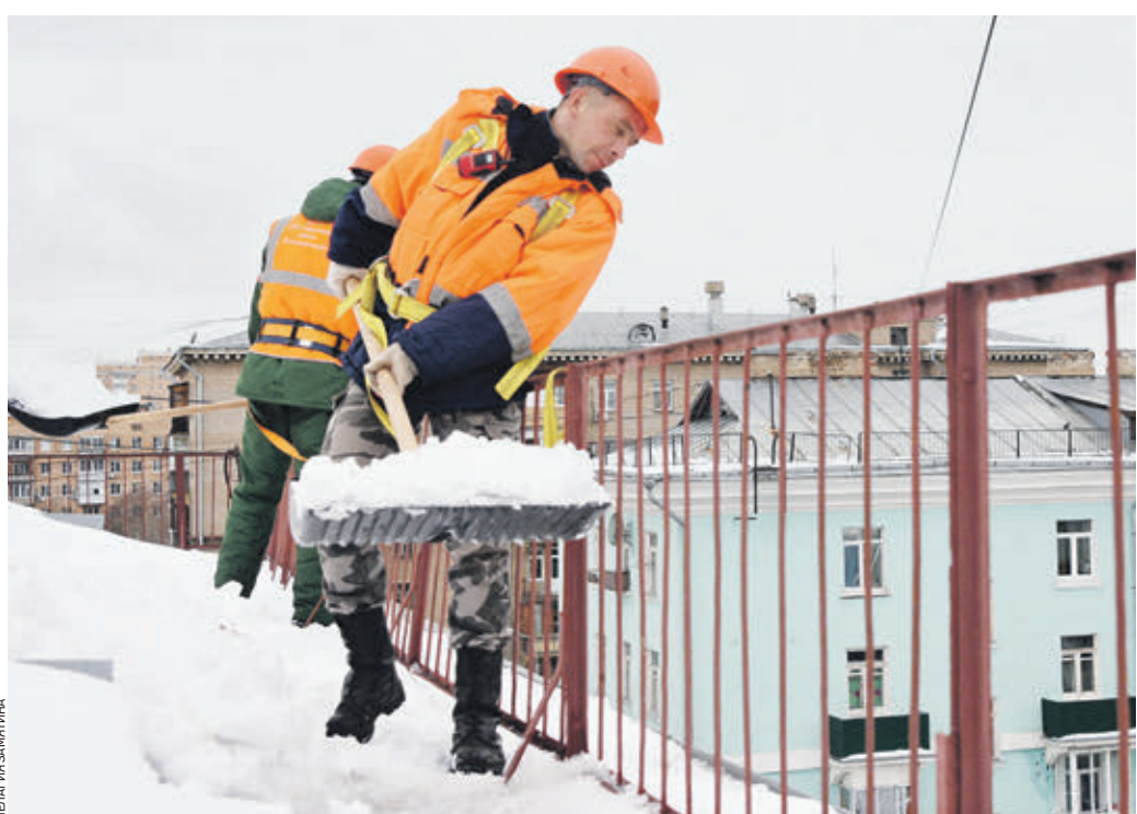
15 февраля 2019 года. Сотрудник ГБУ «Жилищник района Южнопортовый» Евгений Хохлочев очищает кровлю жилого дома
