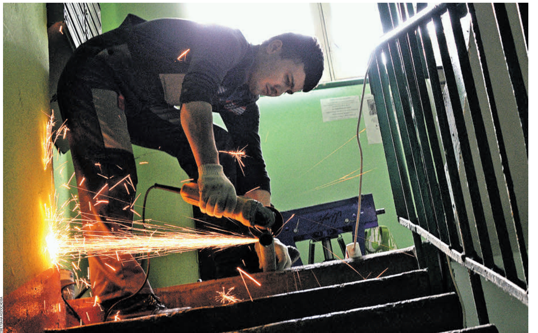
23 ноября 2018 года 12:10 Замена труб горячей воды в многоквартирном доме на улице Рошупкина, 16
