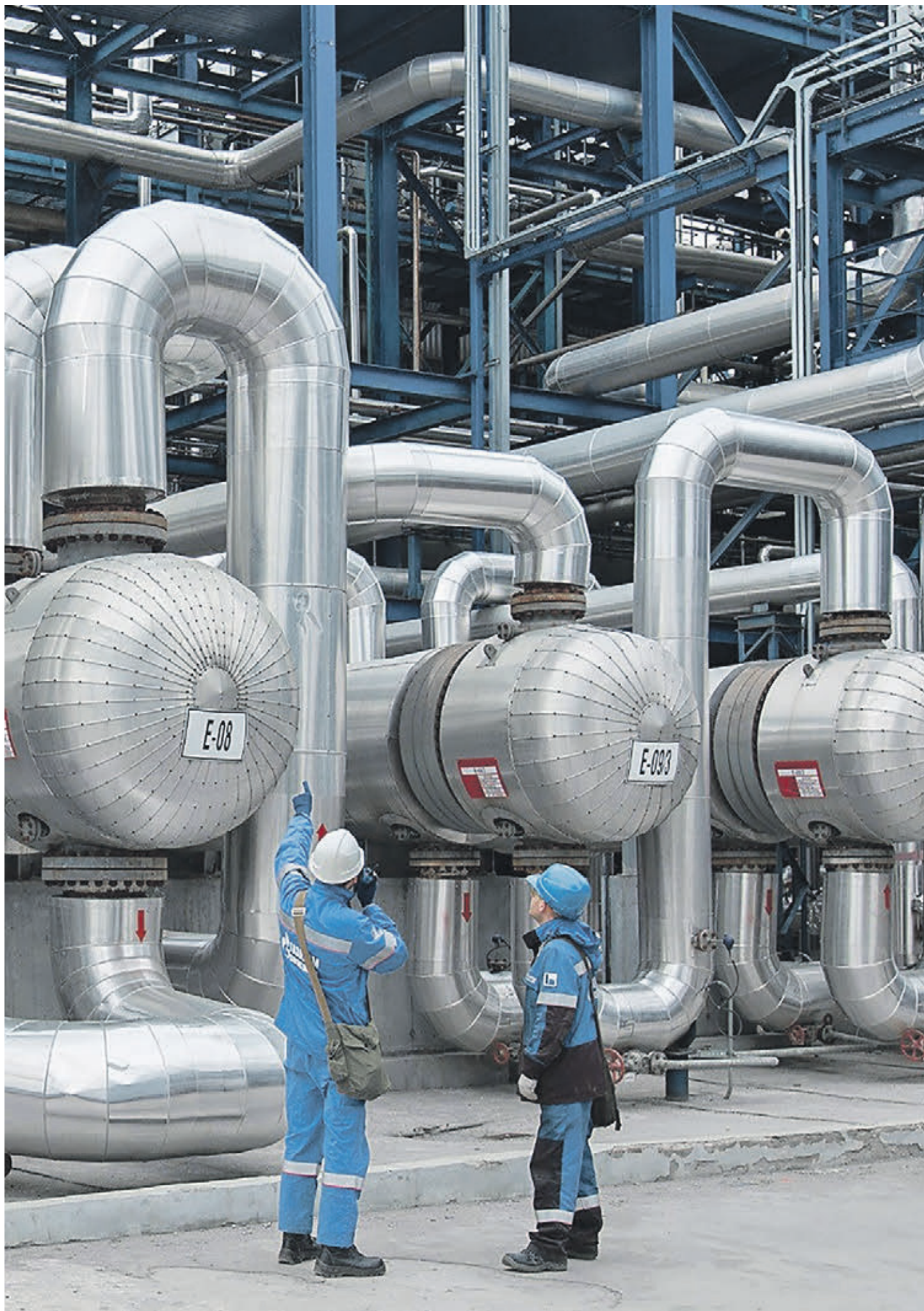
8 мая 2018 года. Специалисты Московского НПЗ возле установки гидроочистки бензина каталитического крекинга, которая позволяет выпускать бензин экологического класса «Евро-5»
