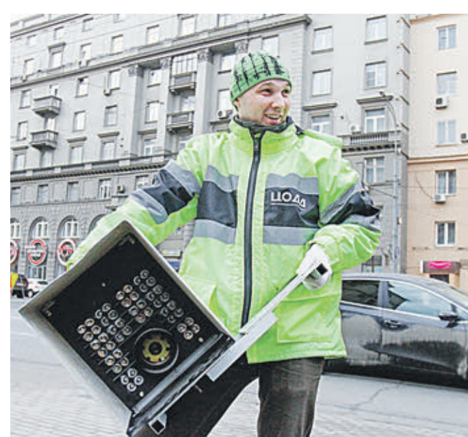
17 апреля 2017 года 11:14 Проспект Мира. Сотрудник ЦОДД монтирует комплекс фотовидеонаблюдения
