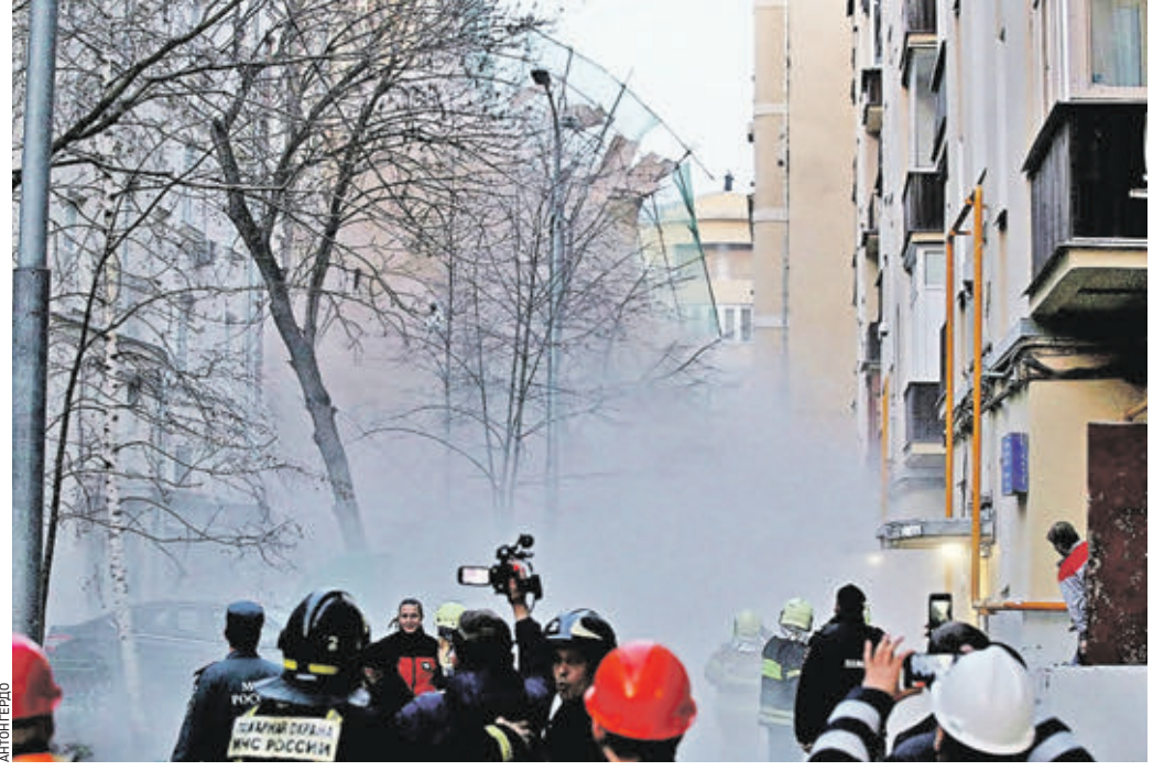
15 апреля 2018 года 19:51 Момент обрушения стены реконструируемого дома в Пушкаревом переулке. Людей внутри не было, никто не пострадал
