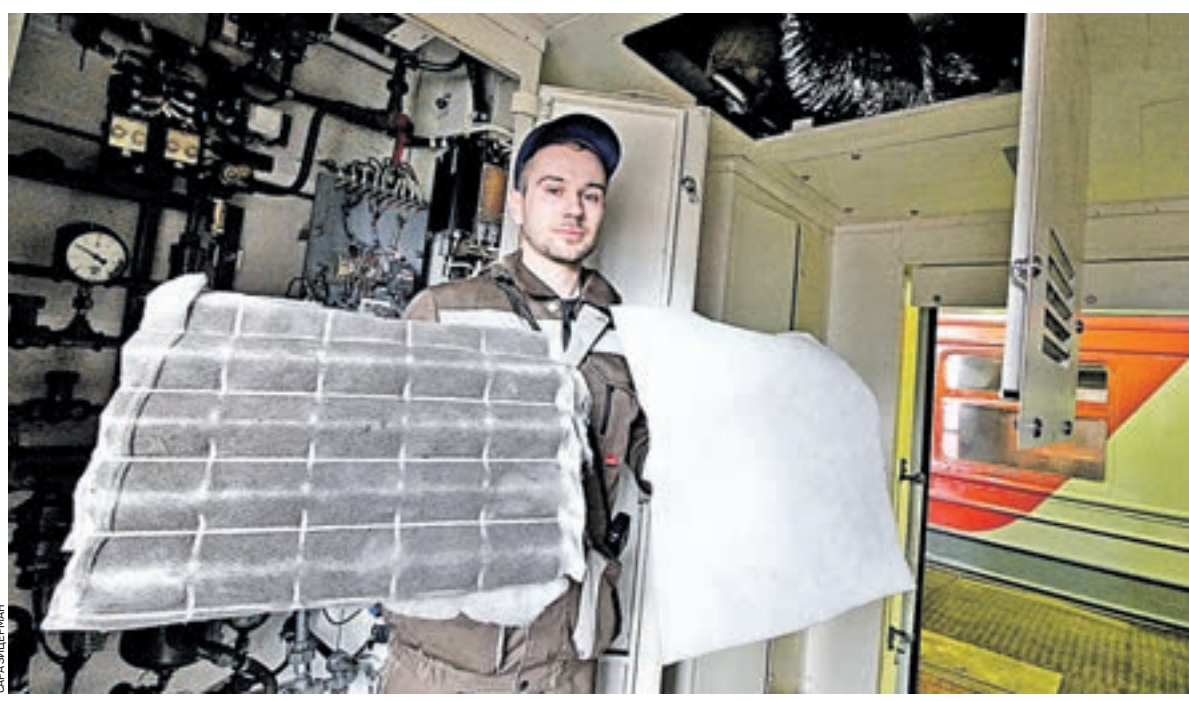
Вчера 09:40 Старший мастер Станислав Соколов демонстрирует фильтры вентиляционного оборудования. Тот, что слева, уже отслужил положенные два месяца и подлежит утилизации. Через минуту в отсеке окажется новый фильтр
