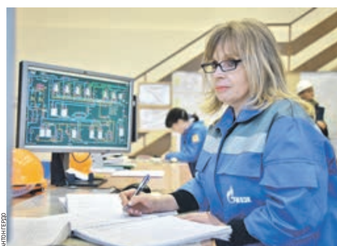
Вчера 16:57 Сотрудник диспетчерского пункта тепловой станции «Некрасовка» следит за работой систем
