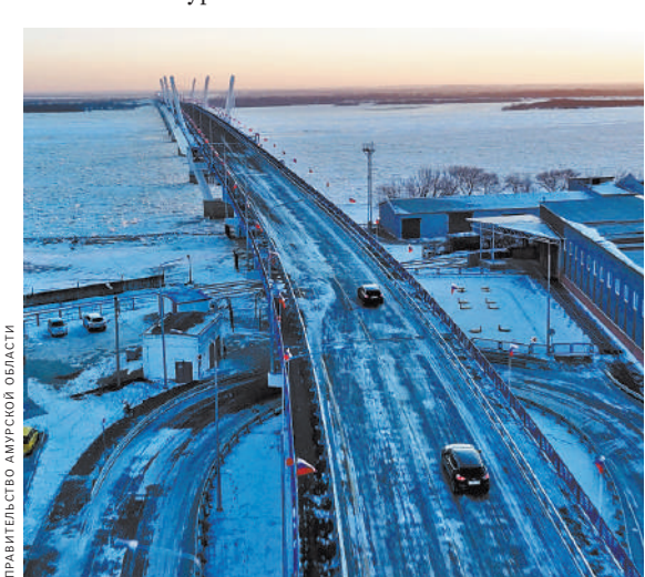
Жители Благовещенска признаются, что новый мост через Зею городу просто жизненно необходим.
