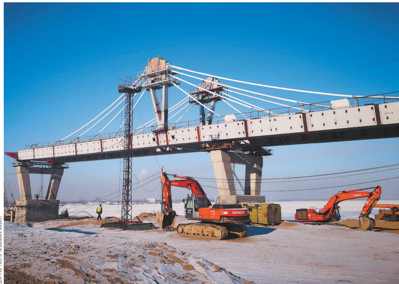
Через реку Амур между российским городом Благовещенск и китайским городом Хэйхэ строится мост.
