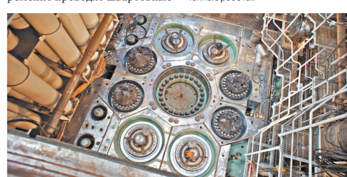
Два реактора ПАТЭС установлены на штатные места и уже интегрированы с другим энергетическим оборудованием. До конца 2016 года предстоит завершить все процедуры, позволяющие начать загрузку ядерного топлива.
