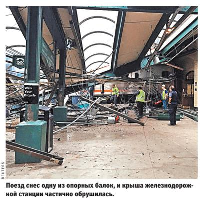
Поезд снес одну из опорных балок, и крыша железнодорожной станции частично обрушилась.
