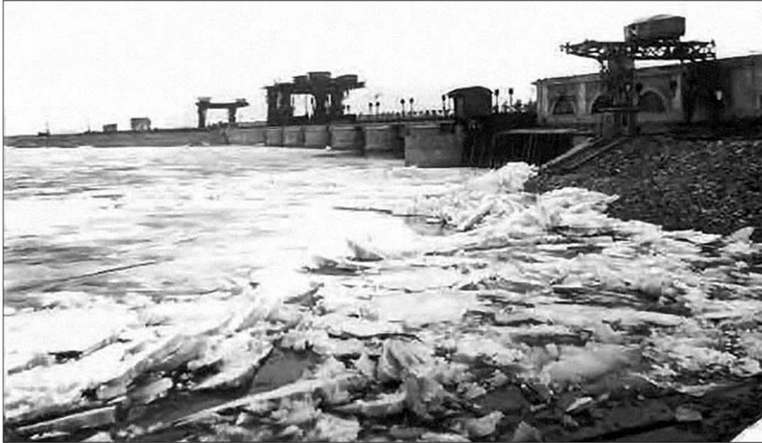
Так выглядел шлюз канала Москва — Волга возле реки Яхромы после сброса в неё воды.
