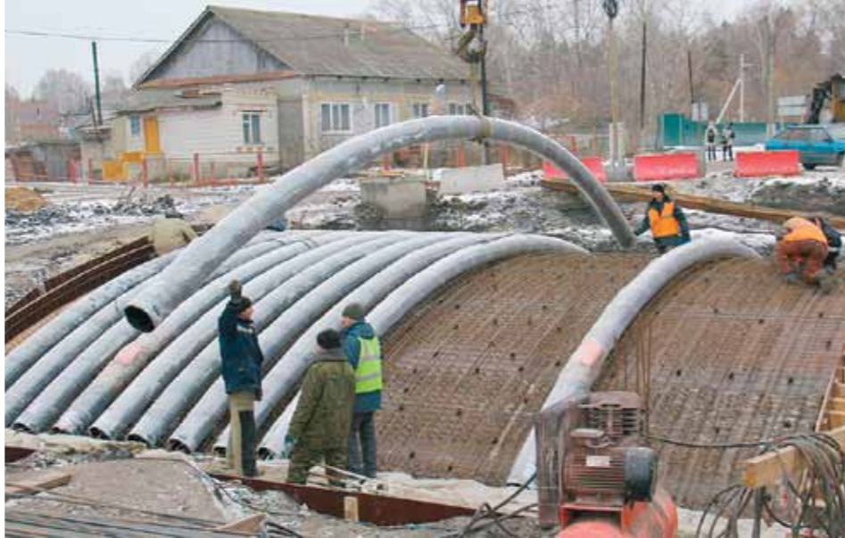
Росатом построил первый углепластиковый автомобильный мост
