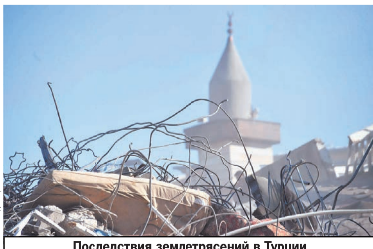
Последствия землетрясений в Турции.
