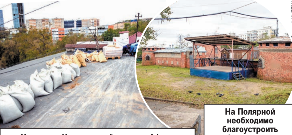
Крышу на Черемуховой после тайфуна решили не латать, а полностью перестелить.
