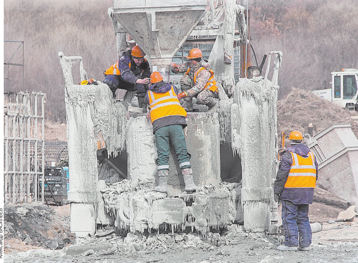
Техника на месте работает даже в холода.
