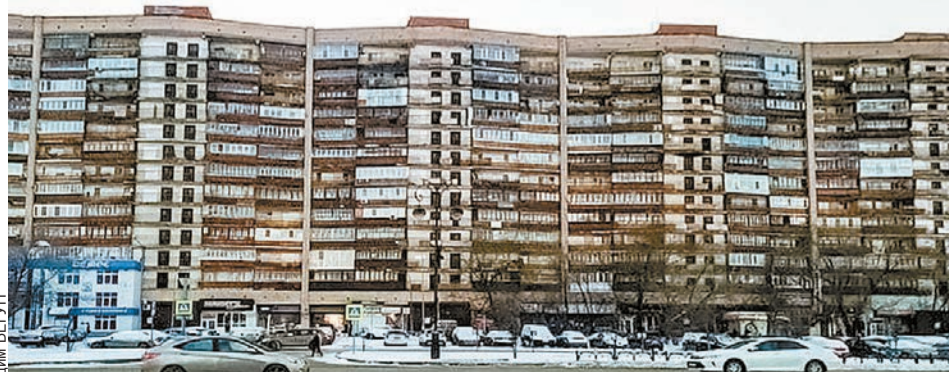
Ремонт фасада дома начнется через три года.
