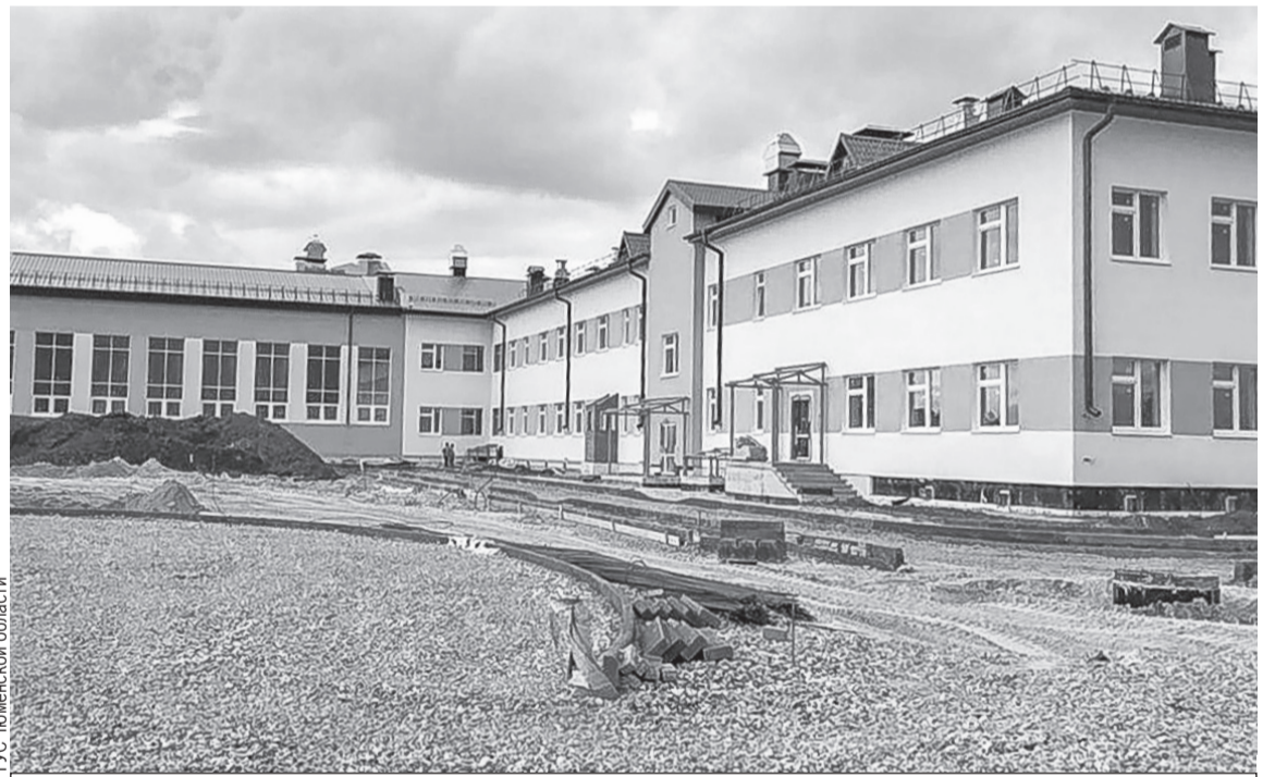
В микрорайоне Казарово занялись благоустройством дворовой территории.
