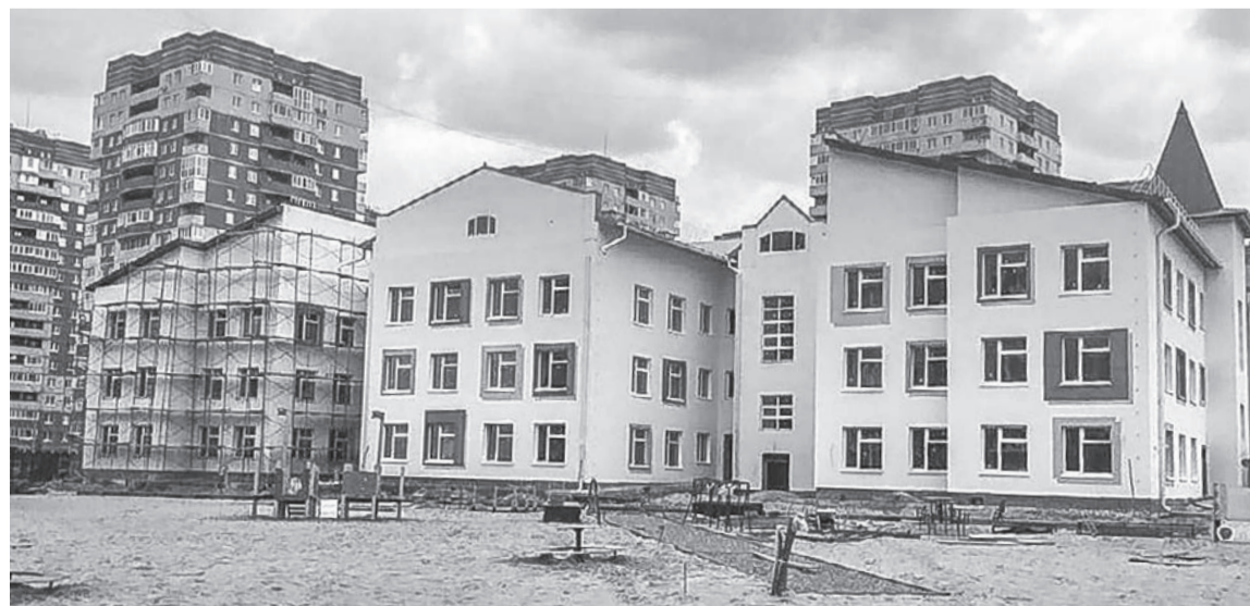
Детский сад в ЖК «Суходолье»: строители вышли на финишную прямую.
