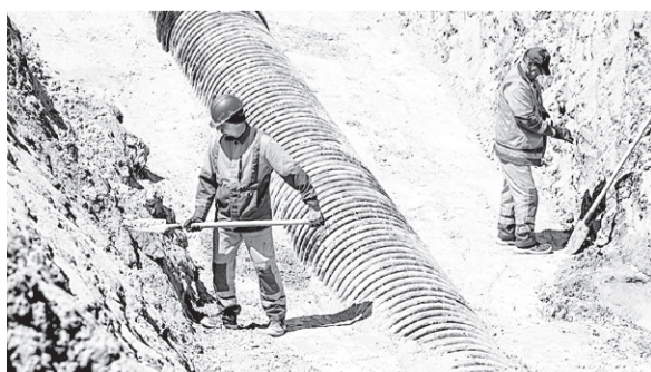
Компания обеспечит микрорайон дорожной и инженерной инфраструктурой.
