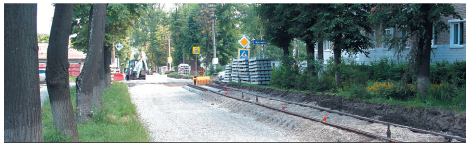
На участке дороги, пересекающем ул. Льва Толстого, рабочие демонтировали плитку и прокладывают новые рельсы.
