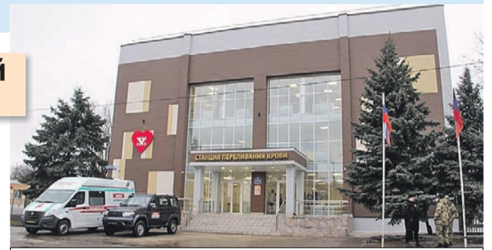
Строительство нового перинатального центра в Донецке.
