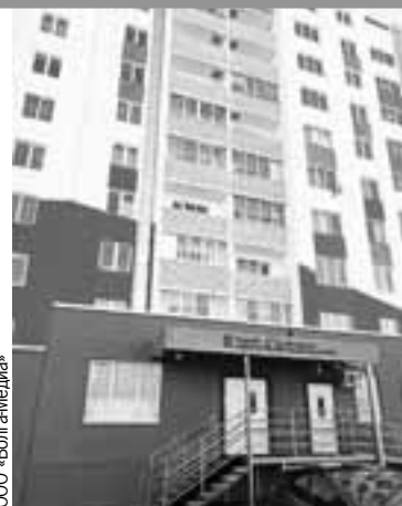
Проект по строительству был реализован за 1,5 года.
