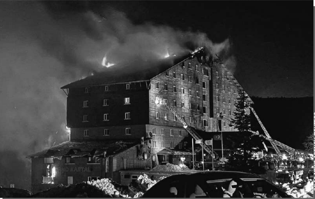
Облицованный деревом горный отель вспыхнул факелом. Сигнализация не сработала, автоматической системы пожаротушения в гостинице вообще не оказалось. Лестницы спасателей не доставали до верхних этажей, где люди оказались в огненной ловушке.
