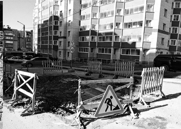
Ул. Стахановская, дом №16 со стороны улицы Стахановской Дата съемки 18.08.2020 г. 8 часов 40 минут. Работы не ведутся
