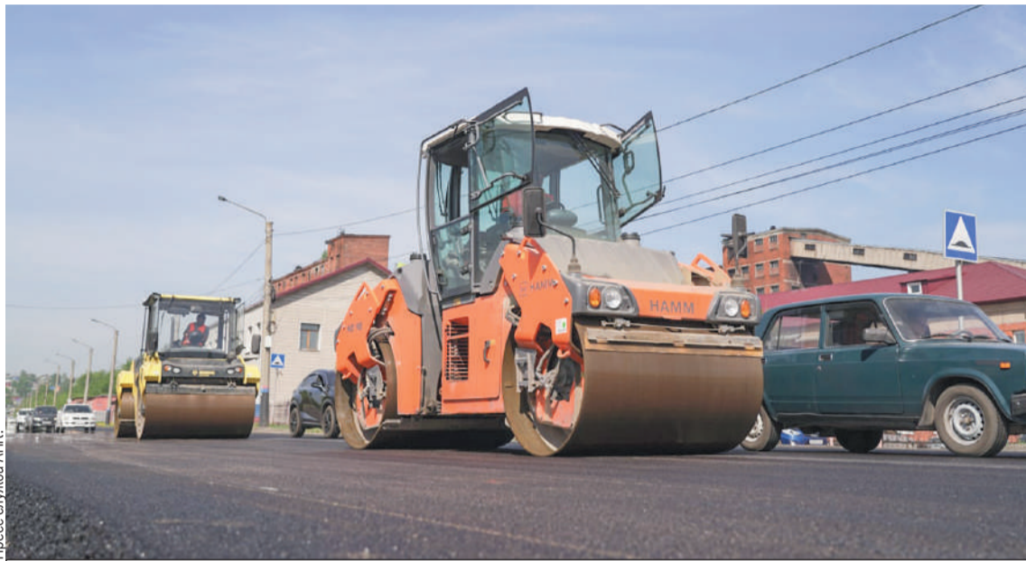
Ремонтные работы будут проводиться по национальному проекту «Безопасные и качественные дороги».
