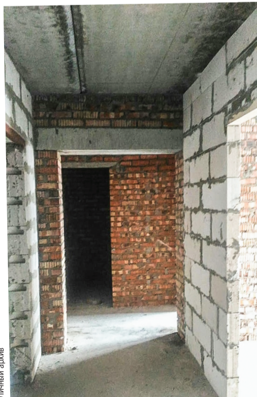
На объекте предстоит еще много работы: установить перегородки, смонтировать инженерные сети, закончить обустройство кровли.
