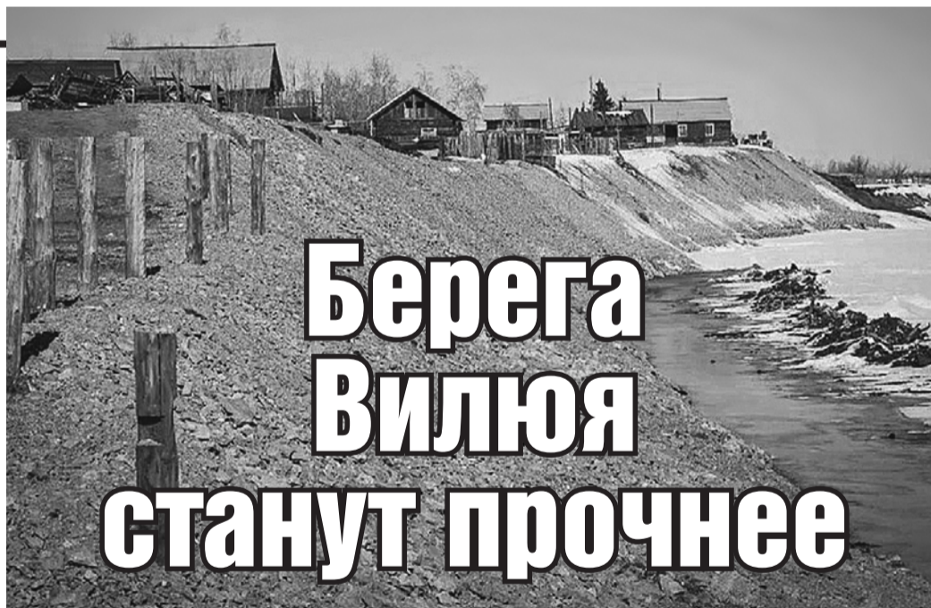
Эти откосы сделают более пологими и отсыпят прочным материалом.
