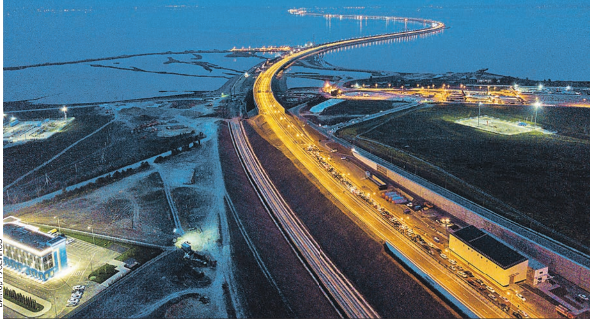
Крымский мост пересек Керченский пролив не по самому короткому маршруту. Но способен выдержать и ледоход, и землетрясение. И вообще - красавец. Сахалинский будет не хуже.
