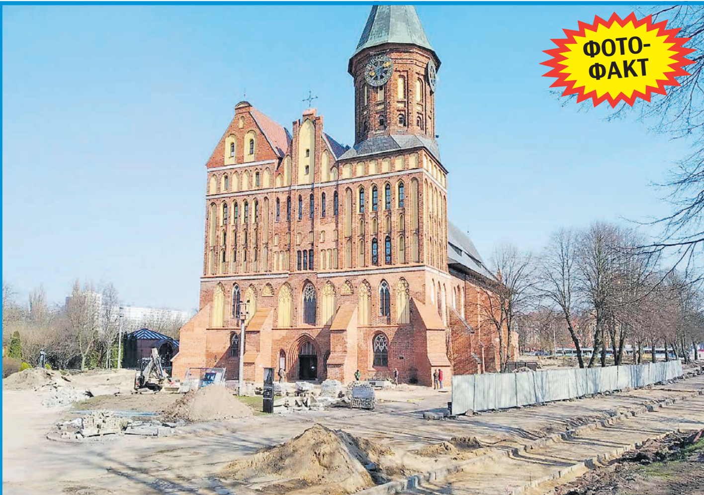
Так сейчас выглядит территория вокруг Кафедрального собора на острове Канта. Рабочие продолжают снимать старое покрытие перед предстоящей реконструкцией. Скоро здесь начнут свои раскопки и археологи.
