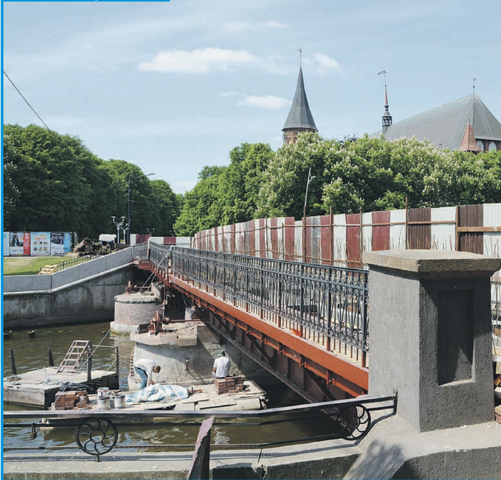
Медовый мост на остров все еще на ремонте.
