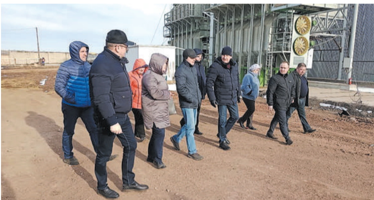
Заместитель председателя правительства Иркутской области Владимир Читоркин и министр сельского хозяйства региона Илья Сумароков проинспектировали строительную площадку будущего маслозавода по переработке рапса на базе «Рассвет».
