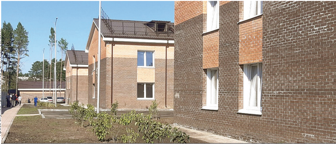
В Тулуне продолжается строительство домов для пострадавших от наводнения.
