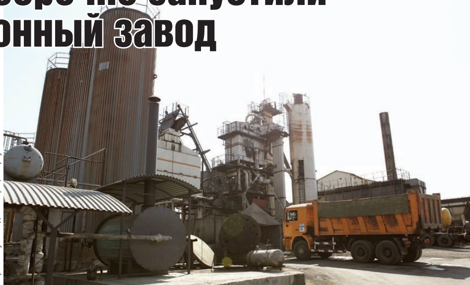
Завод выпускает, в том числе, щебеночно-мастичный асфальтобетон, разработанный специально для местных условий.
