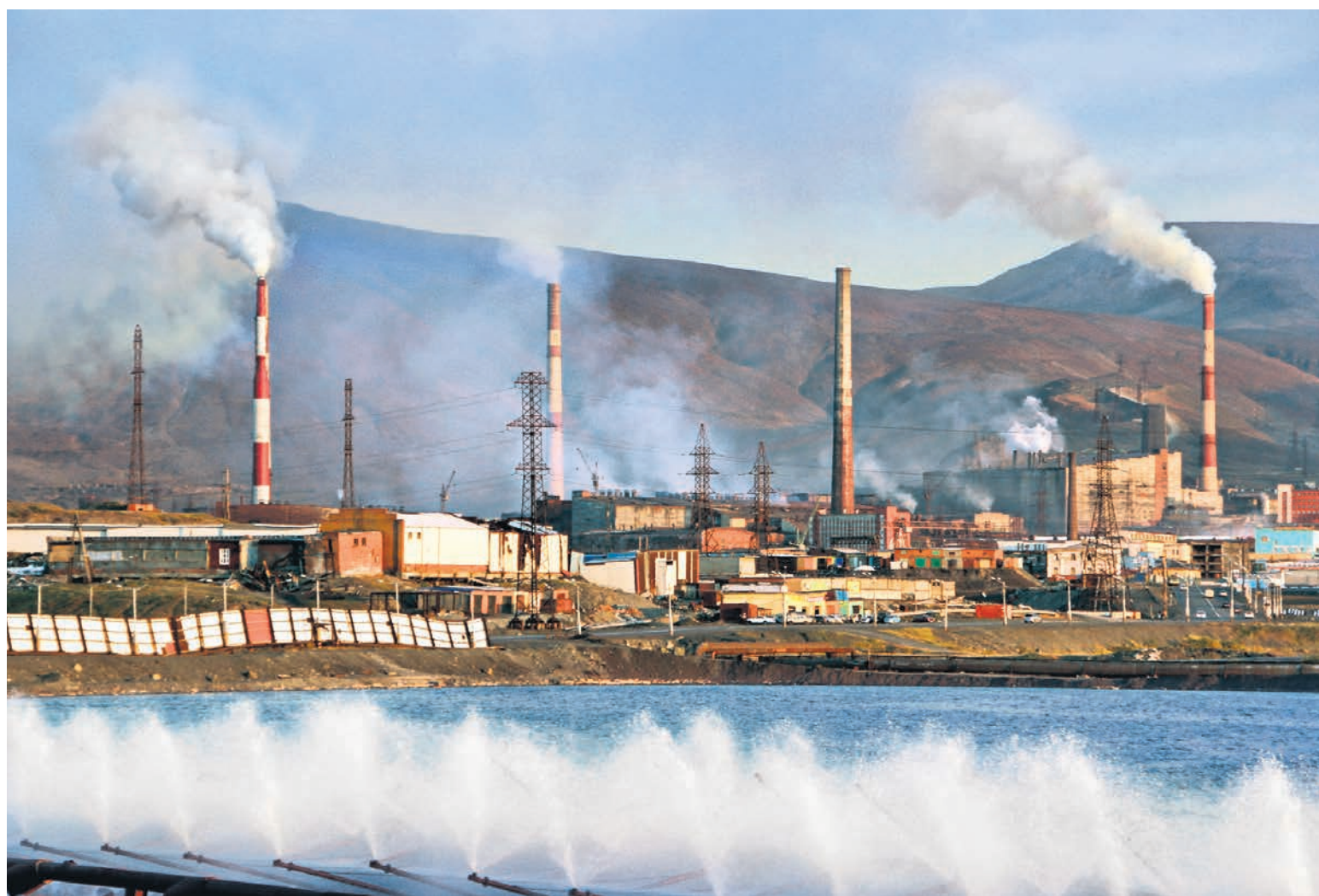
В Думе считают, что скорость строительства опасных производств важнее, чем оценка их экологической безопасности ФОТО АЛЕКСАНДРА ЧИЖЕНКА
