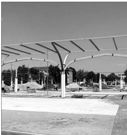
Работы на вокзале будут вестись ночью и продлятся до сентября 2024 года.
