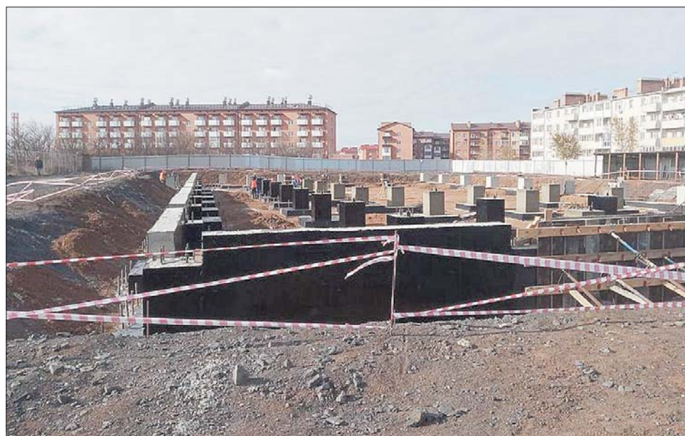
На строительство Центра тяжёлой атлетики им. В. Алексева потратят свыше 144 млн рублей.
