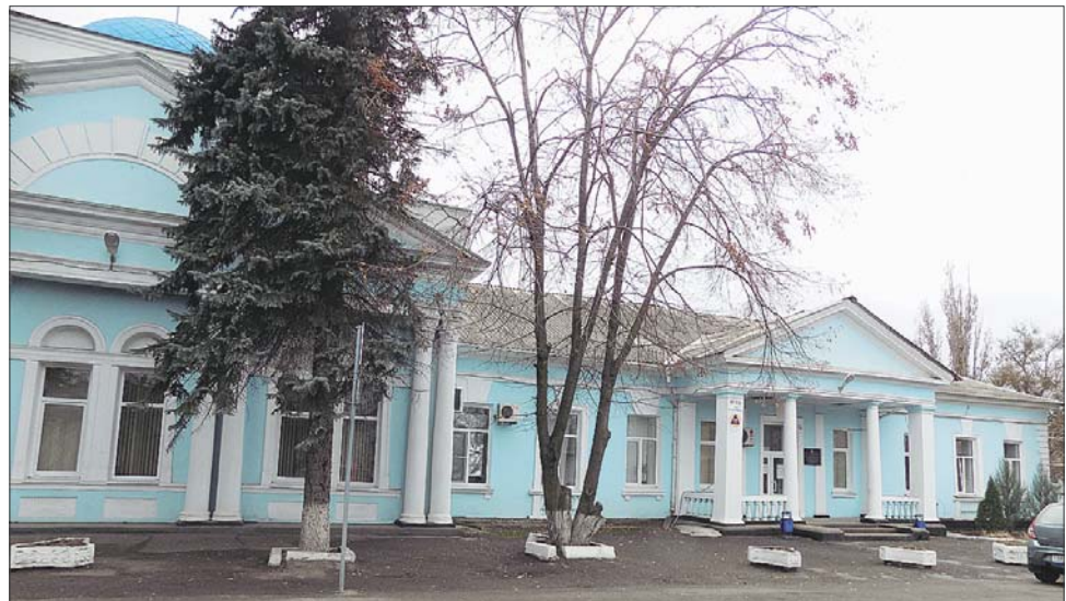
Здание ВГСЧ на Петровке было построено в тридцатые годы XX века.
