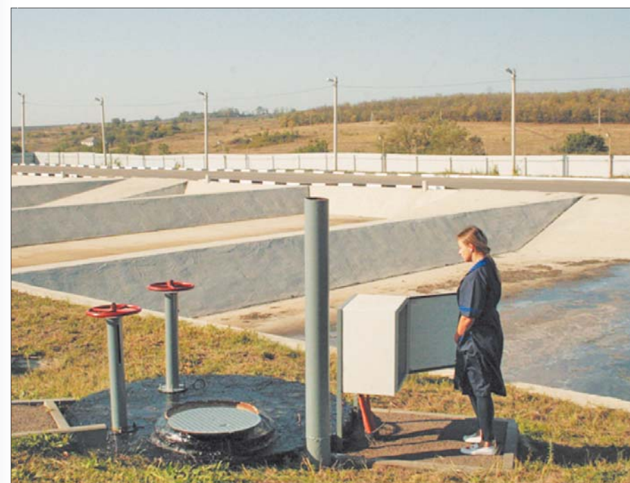
Благодаря запуску очистных сооружений в п.Аютинский, местные нечистоты местных перестанут удобрять реку Дон. Фото с сайта администрации г. Шахты.
