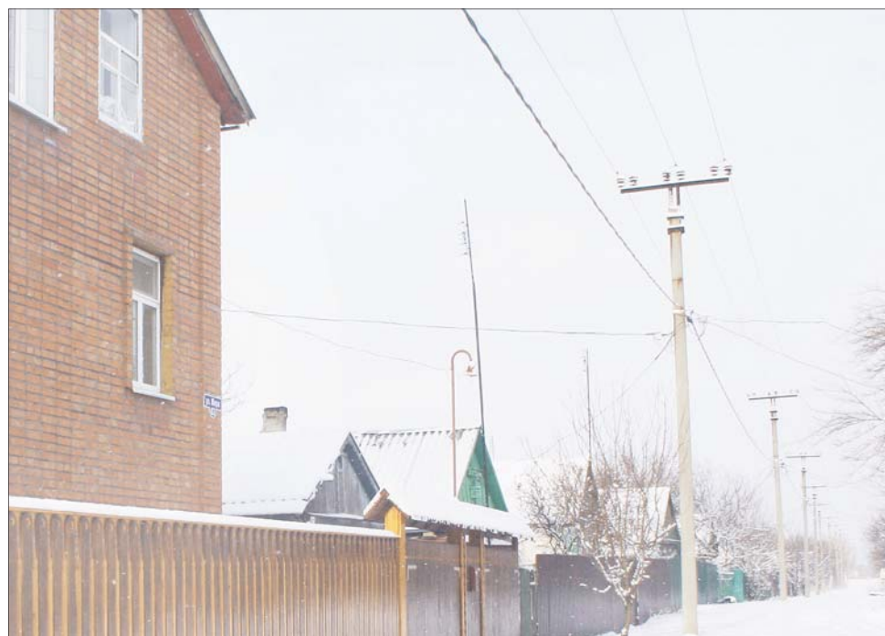
Линии электропередач установлены слишком близко к жилым домам в п. Ново-ГРЭСовский.
