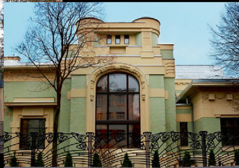
Обособняк Дерожинской. Москва, Кропоткинский переулок, дом 13, строение 1
